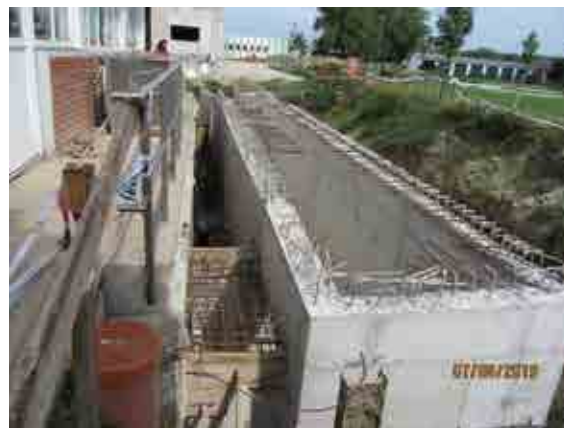
Soproni szennyvíztisztító telep, nagygépház szivótér bővítés és gépi tisztítású durva rács beépítés
