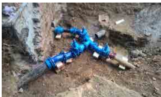
Harka, távvezeték rekonstrukció, csomópont
