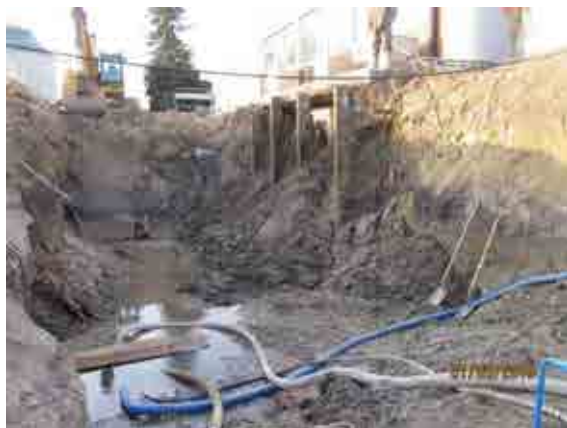
Soproni szennyvíztisztító telep, nagygépház szivótér bővítés és gépi tisztítású durva rács beépítés
