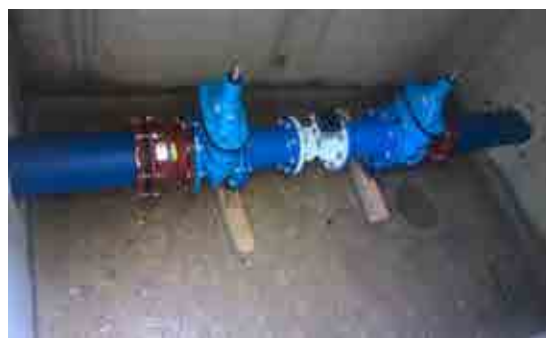
Harka, távvezeték rekonstrukció, akna
