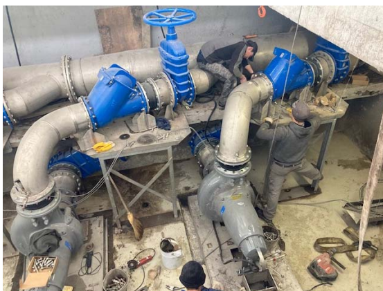
Sopron szennyvíztelep nagygépházi átemelő szivattyú csere
