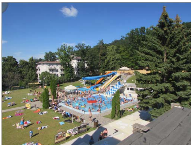
Lővér strand működése az építkezés közben. A felül látható OSB takarófal a port és az építési területet zárta el a strandolók elől
