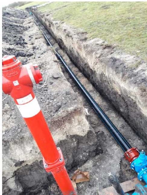
Sopronkőhidai vízrendszer, A7_A kút rendszerre kötése.
