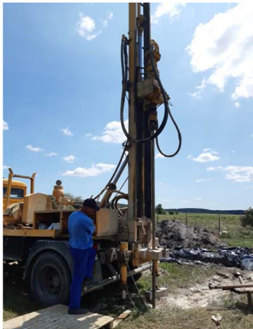
Sopronkőhidai vízrendszer, A7_A kút fúrása
