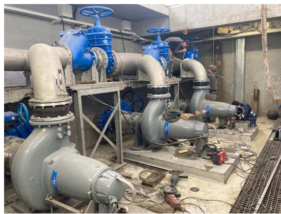
Sopron szennyvíztelep nagygépházi átemelő szivattyú csere
