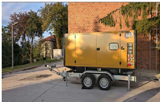
Villa-sori vízműtelep, 160kW-os aggregátor (saját beruházás)
