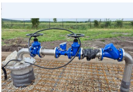
Kút rendszerre kötése: az adott kút szerelvénytára, kút bekötővezetéke, gyűjtővezetékre kötése a mosató tűzcsapcsomópont kialakításával
