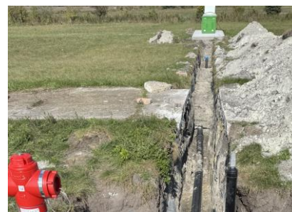
Kút rendszerre kötése: az adott kút szerelvénytára, kút bekötővezetéke, gyűjtővezetékre kötése a mosató tűzcsapcsomópont kialakításával
