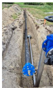
Kút rendszerre kötése: az adott kút szerelvénytára, kút bekötővezetéke, gyűjtővezetékre kötése a mosató tűzcsapcsomópont kialakításával
