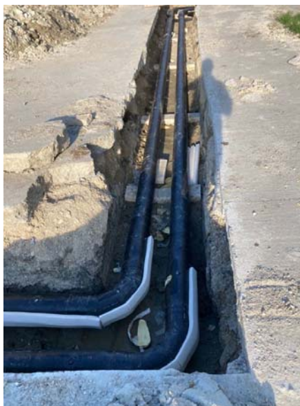
Szennyvíztelep rothasztó torony fűtésű csere
