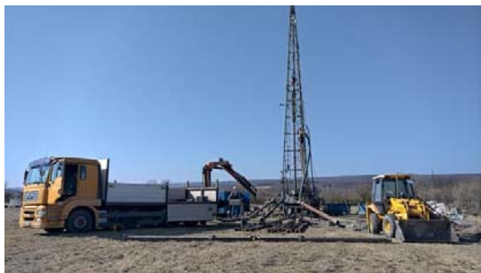
Sopronkőhidai U3 kút fúrása
