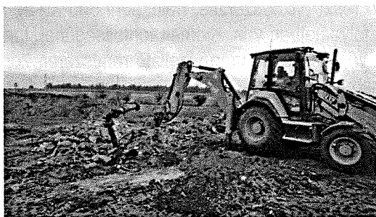
Fertőrákos A3-as kút felújítás
