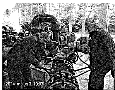
Sopronkőhidai gépház pillangószelep csere
