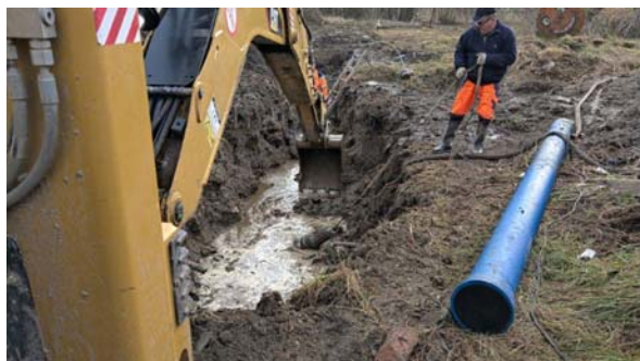
Ágfalvi távvezeték rekonstrukciója
