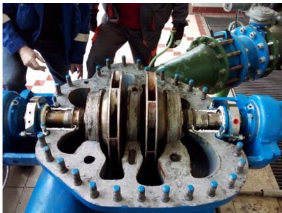
Sopronkőhida, EDH szivattyú felújítása
