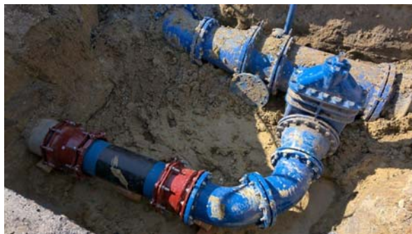
Sopron, Mély úti utépítéssel összefüggésben épült DN 500-as vízvezeték átkötése
