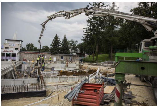
Lővér fürdő, építési munkálatok
