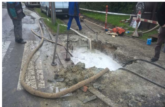
Sopron, Lővér krt. csőtörés
