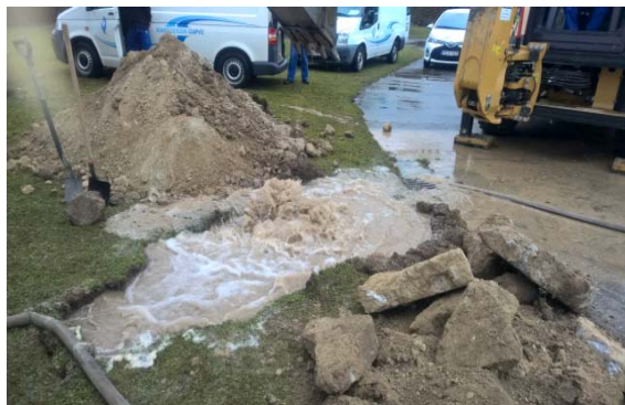
Sopronkőhida csőtörés
