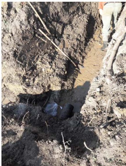
Kópházi szennyvíznyomó vezeték szakítás
